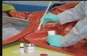
補修部の汚れや油分を除去し、接着剤を塗布
