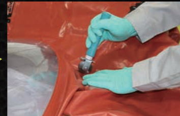
専用ローラーを使用し、パッチを貼付け
