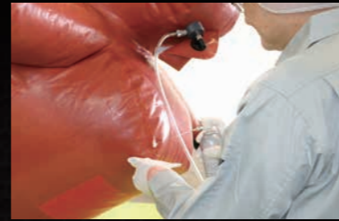
ガス漏れ用検知液を使用した修理部位の特定
